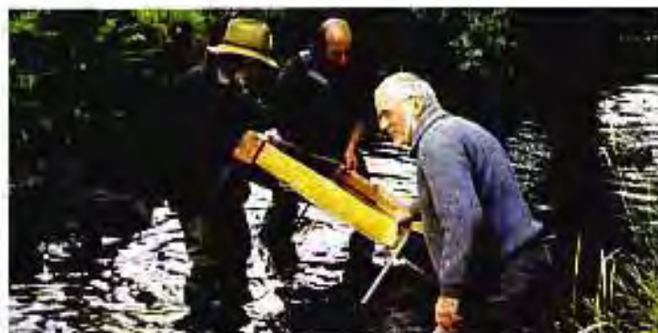
Installation d'une frayère sur le Mousse à Chenereilles
