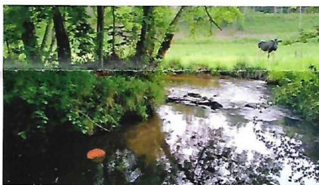
Travaux de l'EPAGE sur le Mousse
